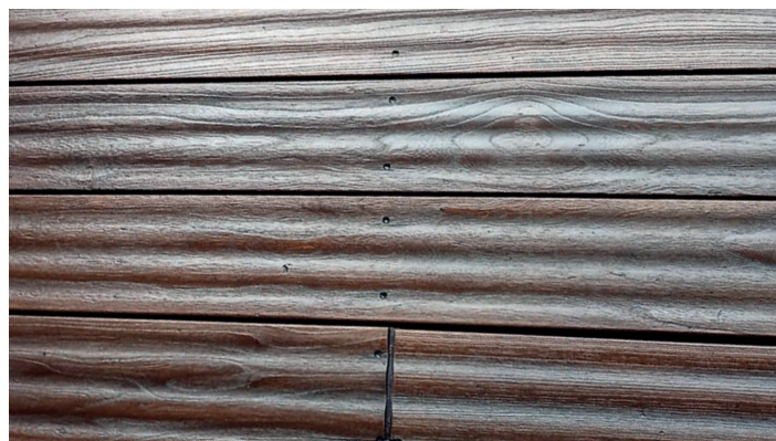
Terrasse renouvelée en thermo-frêne après avoir été finie avec DeckFinish Color Dark Brown.
